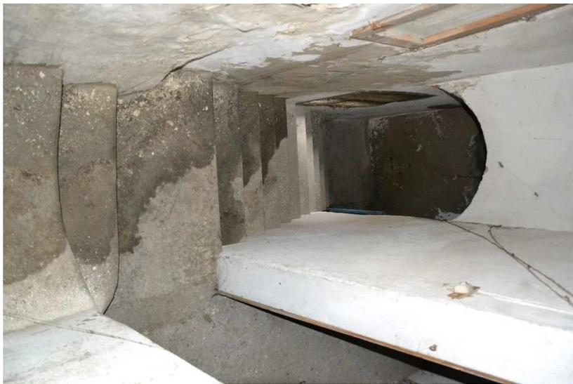
Il vano scala a rampa unica esistente ricavato all'interno dello spessore del muro cinquecentesco non presenta nessuna particolarità di rilievo, è costituita da gradini in muratura con piano di calpestio in cemento per tutta la larghezza del gradino stesso. Inoltre la comune ringhiera di protezione dei primi dieci gradini è in ferro verniciato sul tipo delle ringhiere degli anni '60.
